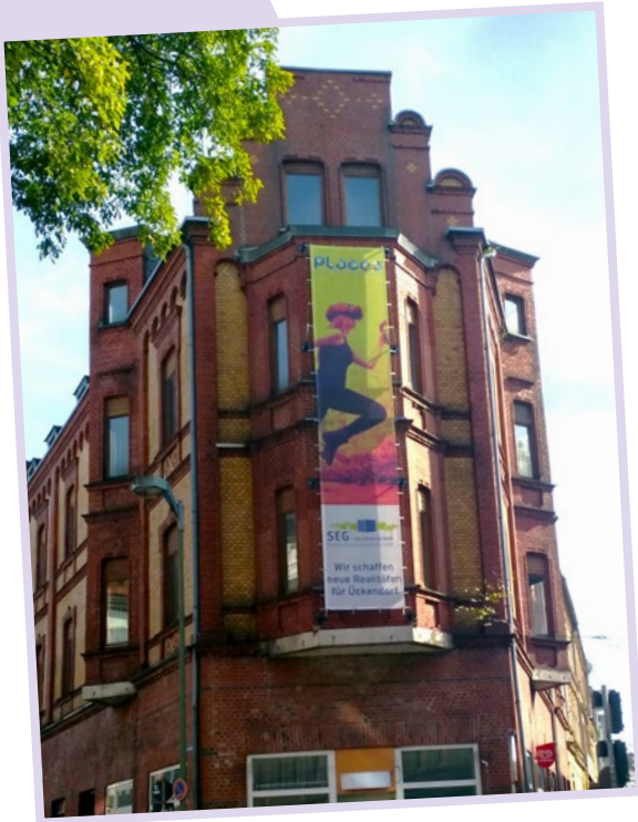
Ein Banner der Stadterneuerungsgesellschaft beschreibt die Gelsenkirchener Strategie: „Wir schaffen neue Realitäten für Ückendorf“
