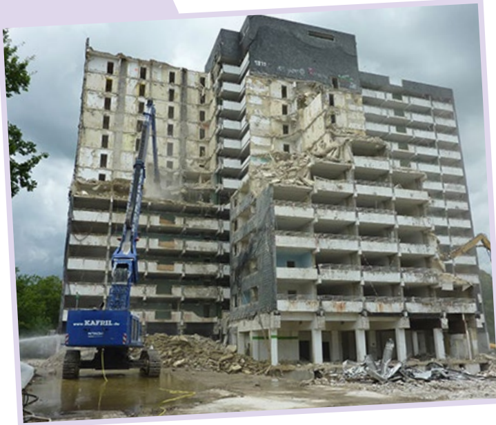
Rückbau des Gebäudekomplexes Schwedter Straße 38 in Gladbeck im Jahr 2021. Quelle: Stadt Gladbeck
