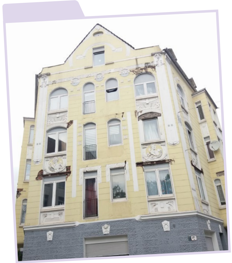
Durch Ansprache wurden Sanierungsmaßnahmen in einem Gründerzeitgebäude in der Dortmunder Nordstadt initiiert
