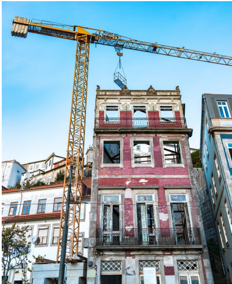
Rückbau einer Problemimmobilie
