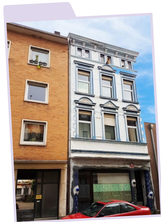
Unbewohnbarkeitserklärung für ein Dachgeschoss wegen Brandschutzmängeln in Düren
