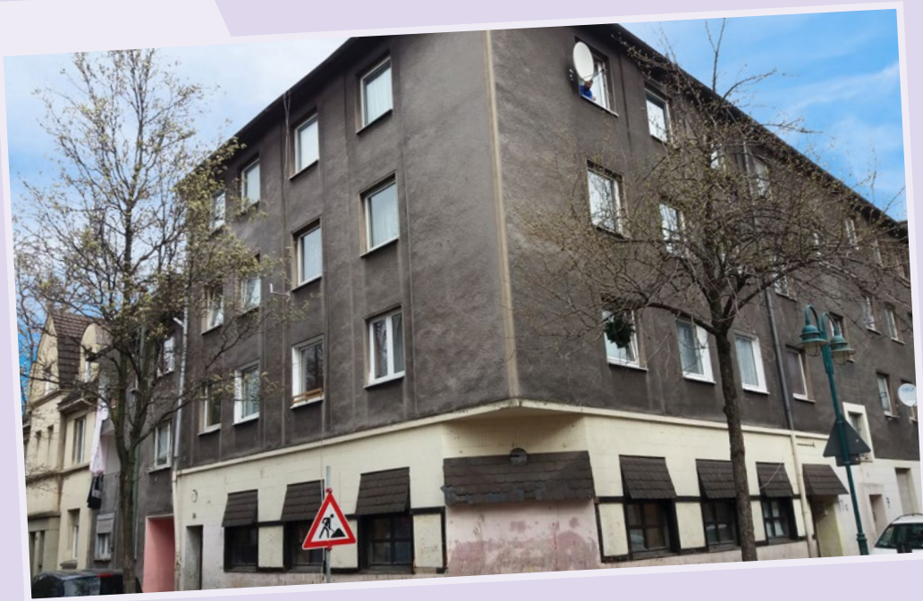
Nach Abwendung einer Zwangsversteigerung freihändig erworbenes Gebäude in Duisburg
