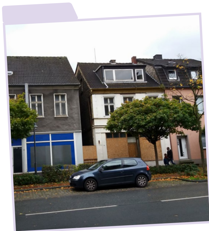
Problemimmobilien in Hamm
